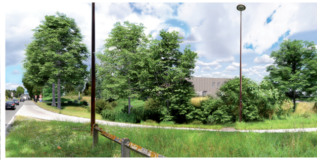
Vue sur la centrale géothermique
